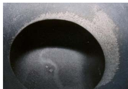
▲ Figure 5 : Érosion de cavitation de pompe à eau
